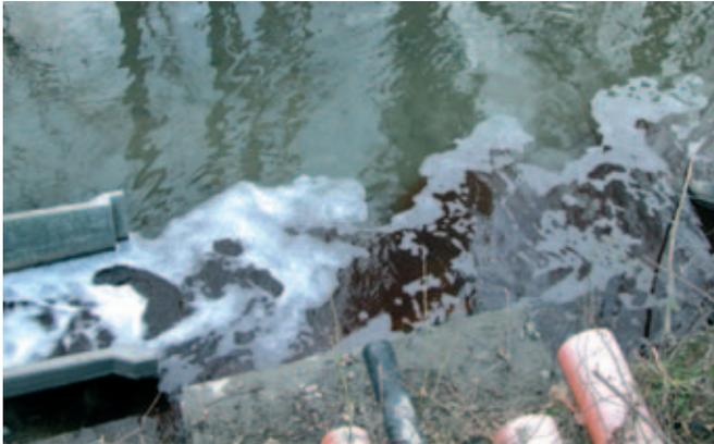
*Vertido al río de aguas residuales textiles, tras ser sometidas a un proceso de depuración completo. Las aguas, pese a estar ligeramente coloreadas, cumplen los parámetros de vertidos estipulados por la legislación (DQO < 100 mg/L,  $N_{NH_3}$  < 15 mg/L SST > 80 mg/L, Cl < 1200 mg/L, color: no detectable con una disolución 1/20).*
